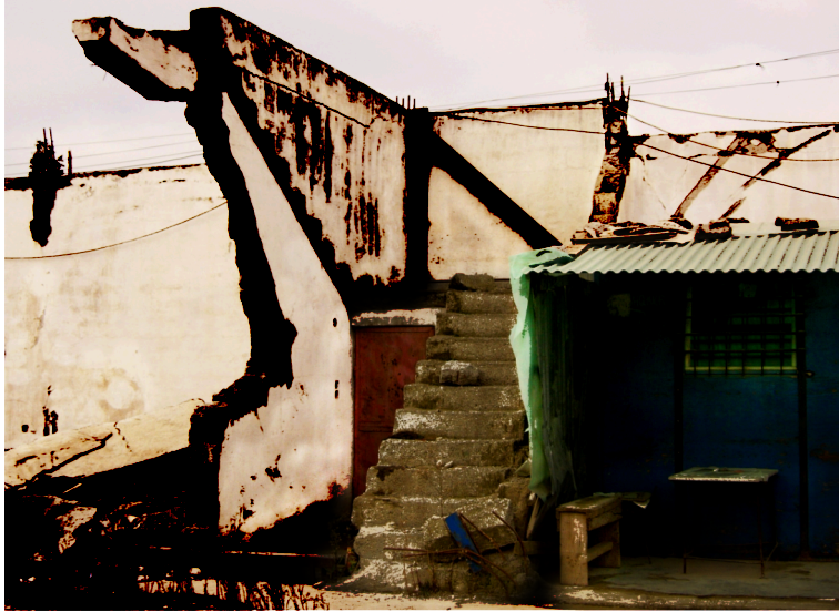
Dégâts provoqués par des supporters de gravatriathlon sur les escaliers d'accès du Grand Stade
